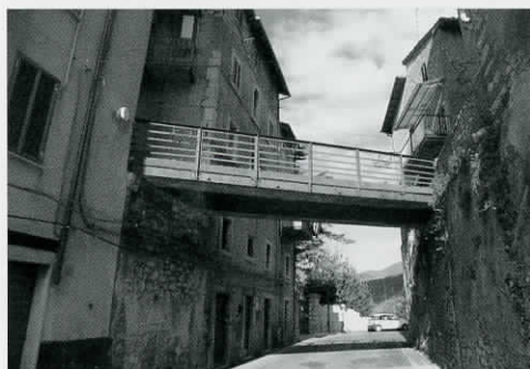
Carpineto Romano, il ponte di ferro
